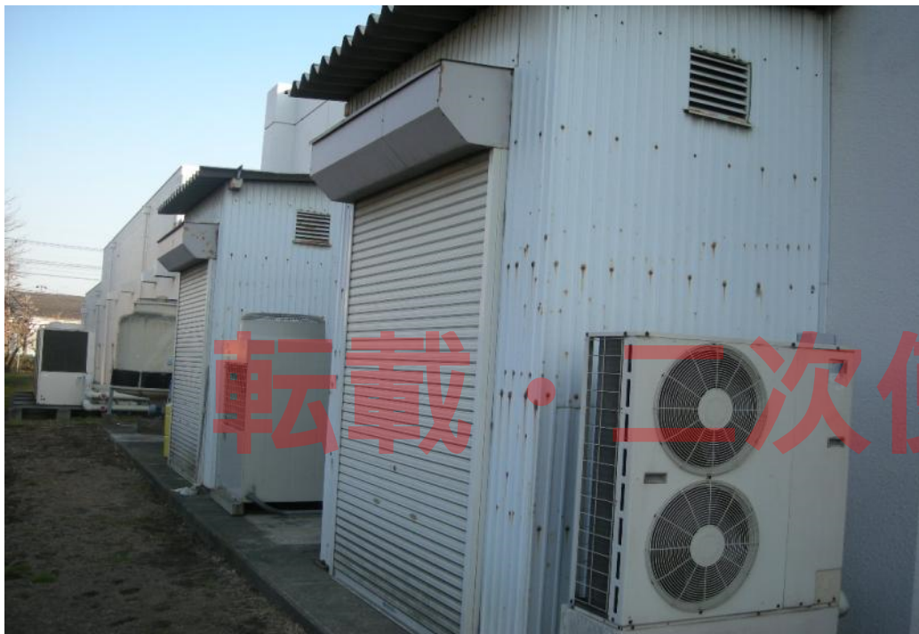
RAC2屋外設備外観
